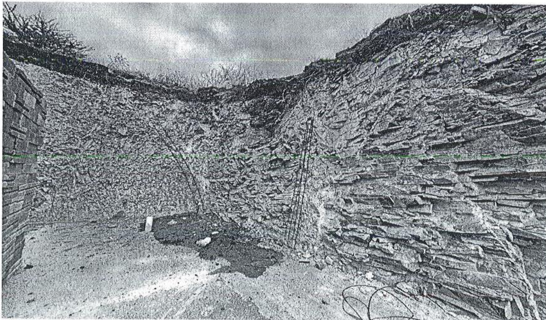
Ilustración 4. Se observa material desprendido y desgaste del muro de excavado.
