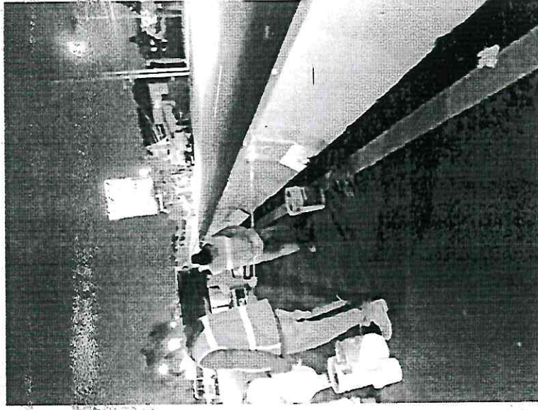
Clave 7 – Pintura epóxica en barrera central
