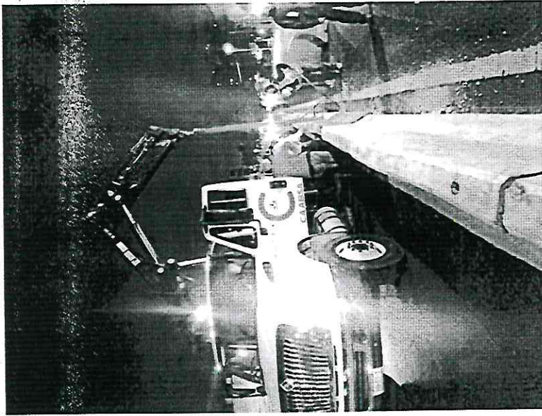
Clave 4 - Retiro de barrera central dañada
