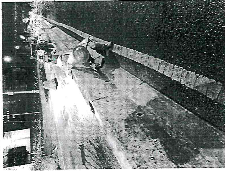
Clave 5 – Reparación de barrera central dañada
