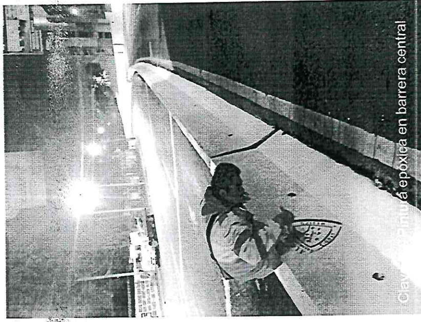
Clave 6 – Pintura en corona de barrera central con microesfera Clave 7 – Pintura epóxica en barrera central
