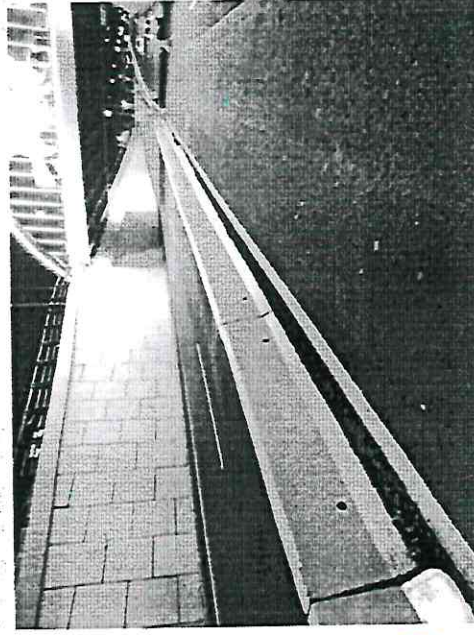
Clave 7 – Pintura epóxica en barrera central
