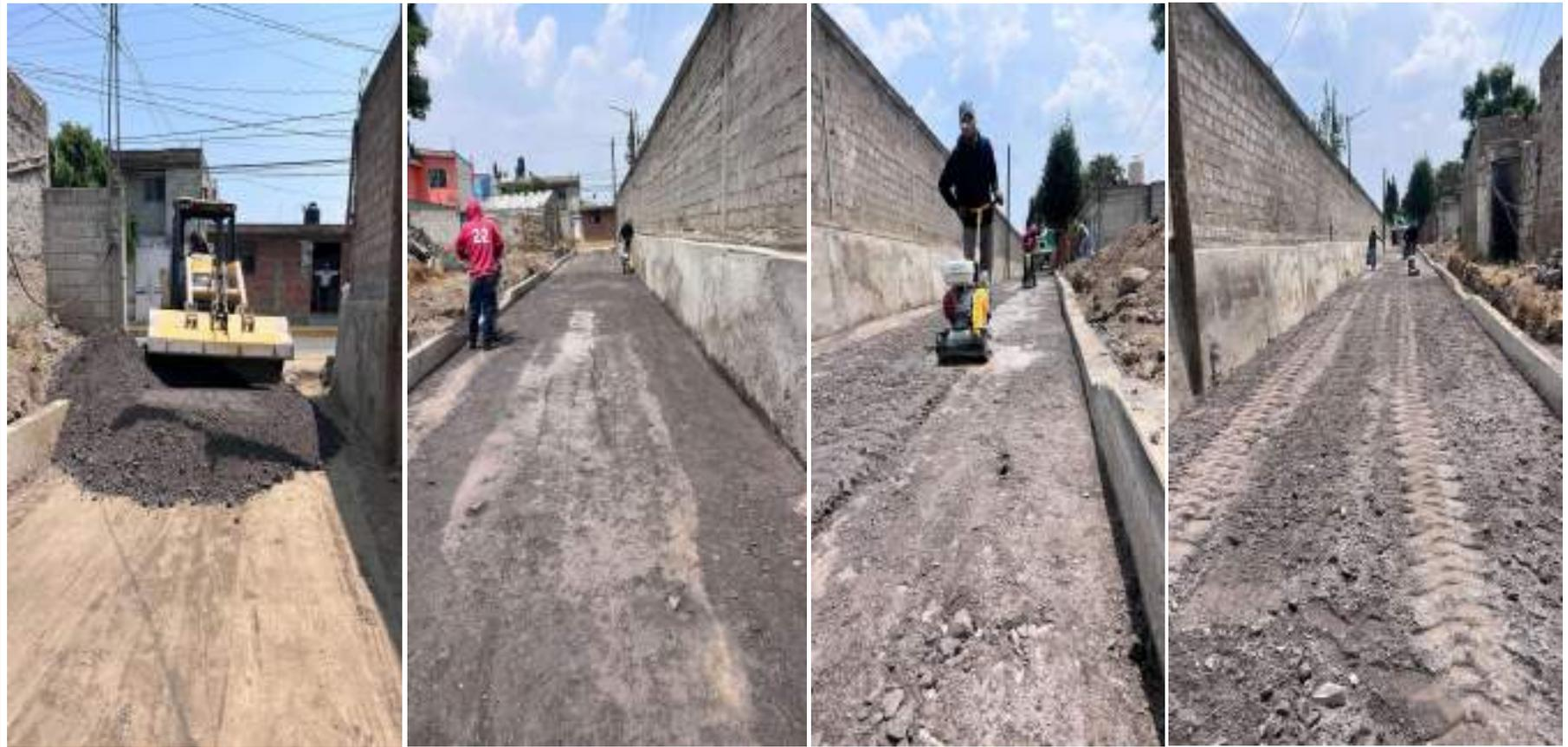
**OBRA: FISM2244037 Construcción de Pavimento de Adoquín**
