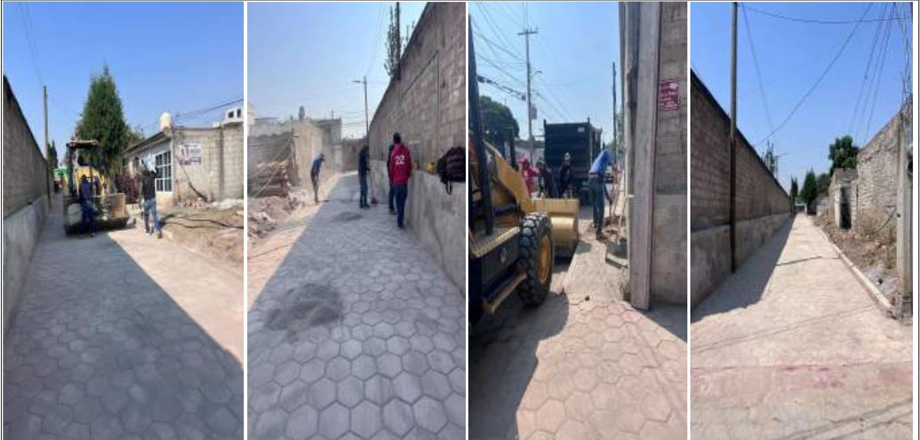
**OBRA: FISM2244037 Construcción de Pavimento de Adoquín**
