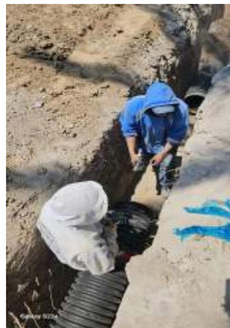
Obra: "Construcción de Drenaje Sanitario"
