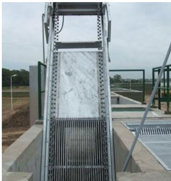
Figura II.42 Reja automática de cadenas
