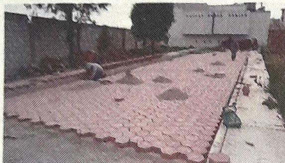
MTTFISM2438004. CONSTRUCCION DE PAVIMENTO CON ADOQUIN, PRIMERA ETAPA (OBRA EN PROCESO)
