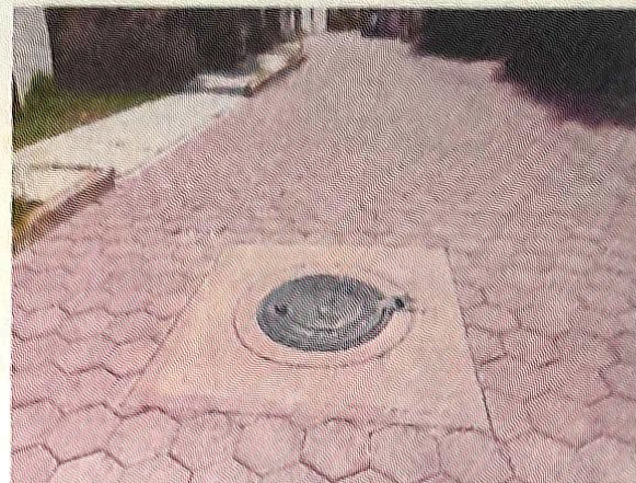
MTTFISM2438001. CONSTRUCCION DE PAVIMENTO CON ADOQUIN (OBRA CONCLUIDA)
