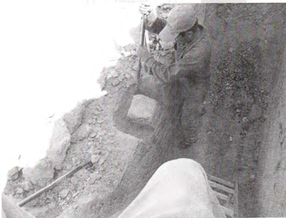
Recuperación de muestra inalterada estrato #4 sondeo PCA-2
