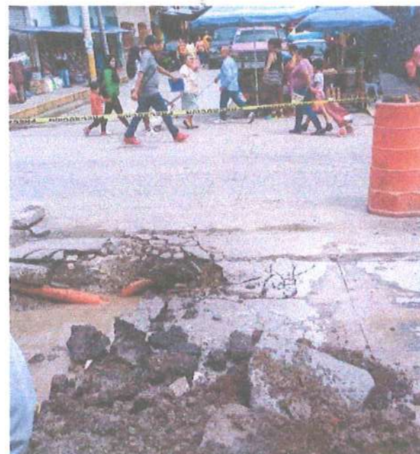
Reparación de la línea de conducción de 10" se encontró un tubo roto de 10 pulgadas en cruce que se dejó la preparación para continuación de línea de ser necesario.
