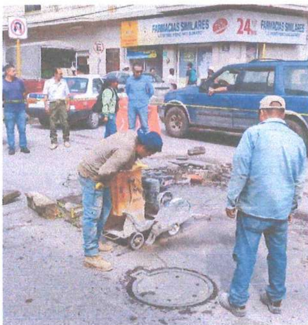
Reparación de la línea de conducción de 10" se encontró un tubo roto de 10 pulgadas en cruce que se dejó la preparación para continuación de línea de ser necesario.
