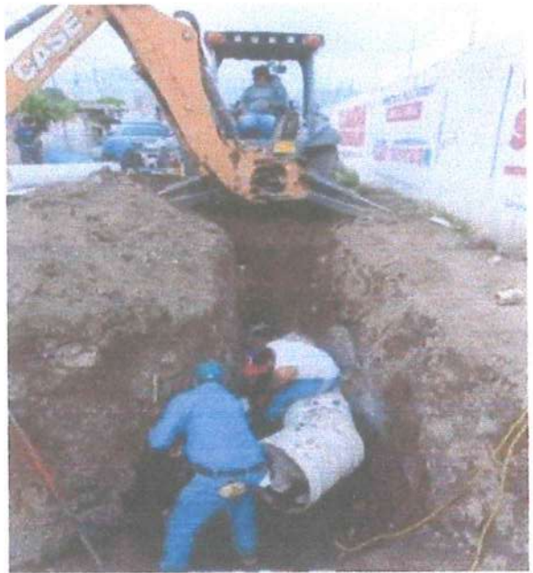
Reparación de la línea de conducción de 20" del tramo de cárcamo de bombeo de Rincón de las Doncellas hacia los tanques de regulación Zarco y Presita.
