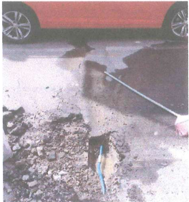
Reparaciones de la línea de Distribución de 3" y cruce de toma domiciliaria en la calle Benito Juárez.
