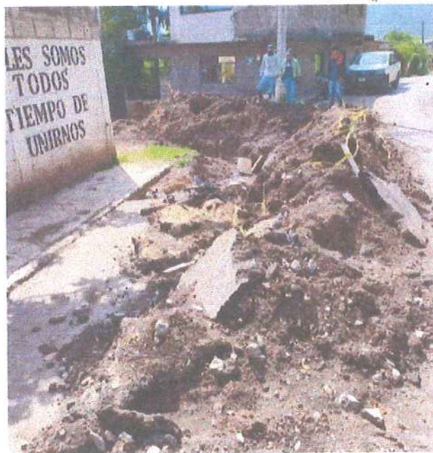
Reparación de la línea de conducción de 12" por falla de pieza especial (codo 45° de 12) del tramo de cárcamo de bombeo de tanque de regulación Zarco 2 a tanque de regulación El Mirador.
