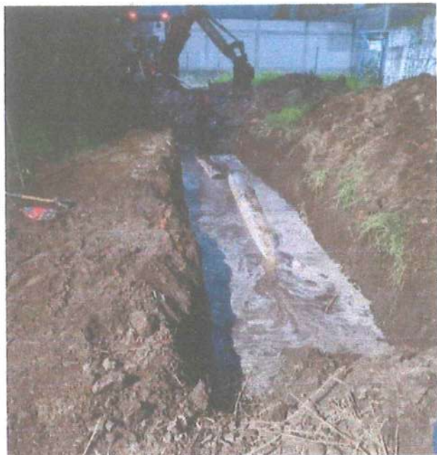
Reparación de la línea de conducción de 16" del tramo de cárcamo de bombeo de Rincón de las Doncellas hacia el tanque de regulación Zarco 1.
