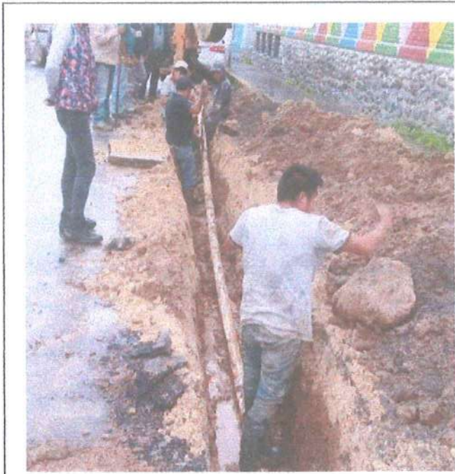
Reparaciones de la línea de Distribución de 3" y cruce de toma domiciliaria en la calle Benito Juárez.
