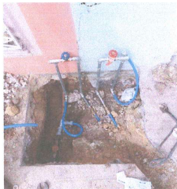
Conexiones nuevas de la línea de Distribución de 3" y cruce de toma domiciliaria diversas calles, tomas que no se solicitaron o ubicaron durante el proceso de la instalación de la línea nueva.
