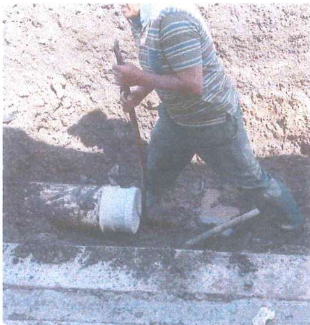
Reparación de la línea de conducción de 10" de la línea de conducción de la red principal de 10" de la Presita. Pendiente de ser necesario un cruce del canal con tubería de acero.
