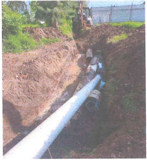
Reparación de la línea de conducción de 16" del tramo de cárcamo de bombeo de Rincón de las Doncellas hacia el tanque de regulación Zarco 1.
