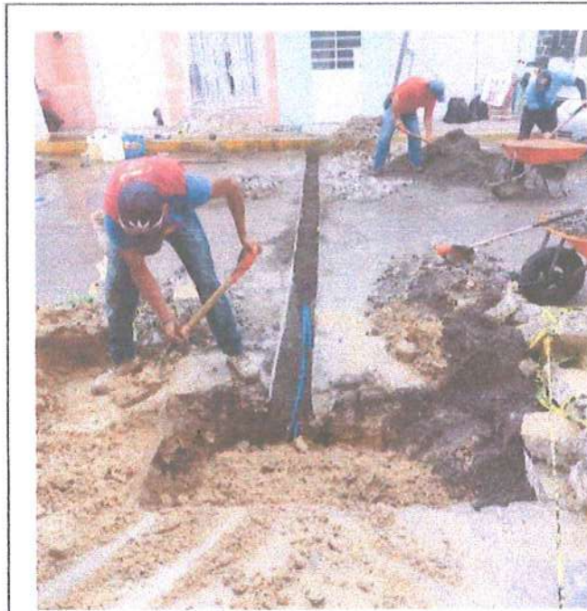
Conexiones nuevas de la línea de Distribución de 3" y cruce de toma domiciliaria diversas calles, tomas que no se solicitaron o ubicaron durante el proceso de la instalación de la línea nueva.
