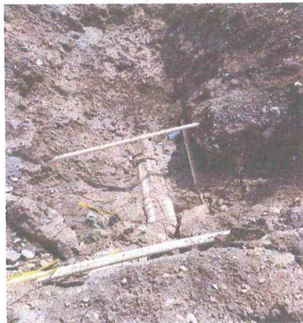
Reparación de la línea de conducción de 12" por falla de pieza especial (codo 45° de 12) del tramo de cárcamo de bombeo de tanque de regulación Zarco 2 a tanque de regulación El Mirador.
