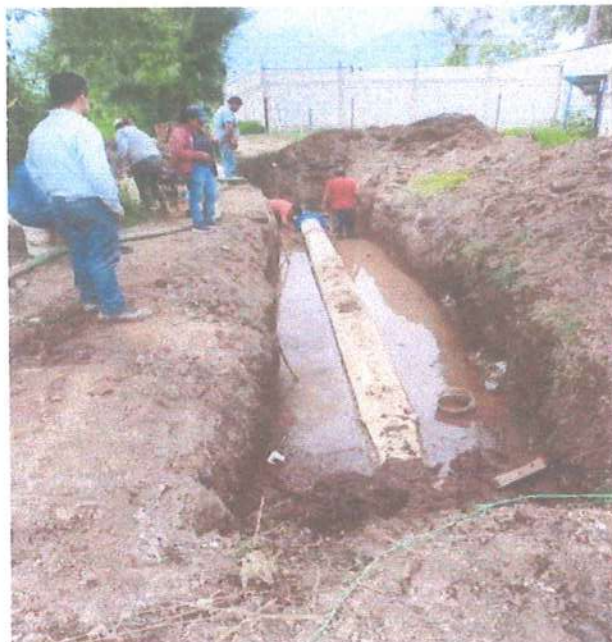
Reparación de la línea de conducción de 16" del tramo de cárcamo de bombeo de Rincón de las Doncellas hacia el tanque de regulación Zarco 1.
