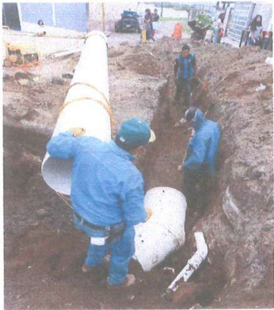
Reparación de la línea de conducción de 20" del tramo de cárcamo de bombeo de Rincón de las Doncellas hacia los tanques de regulación Zarco y Presita.
