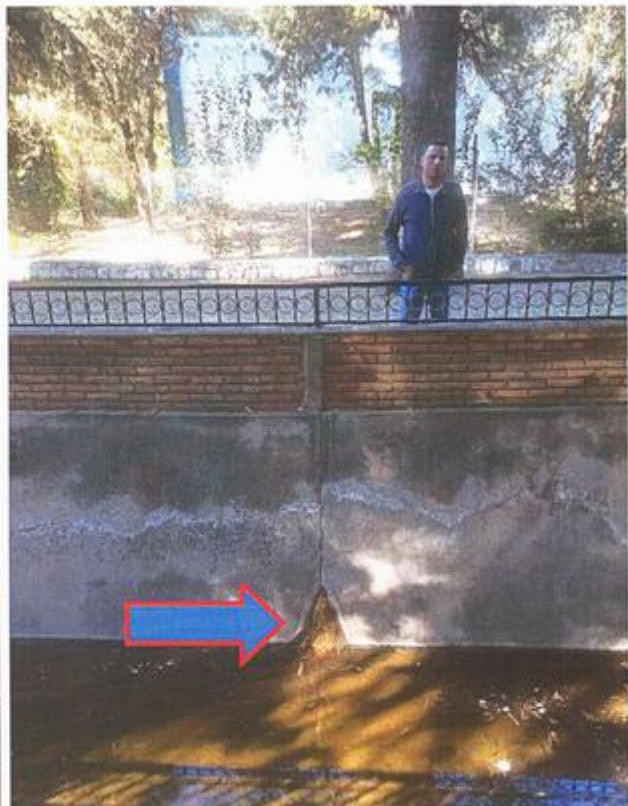
Fig. 3.1 Filtraciones en el canal que se encuentra en las afueras de la alberca.
