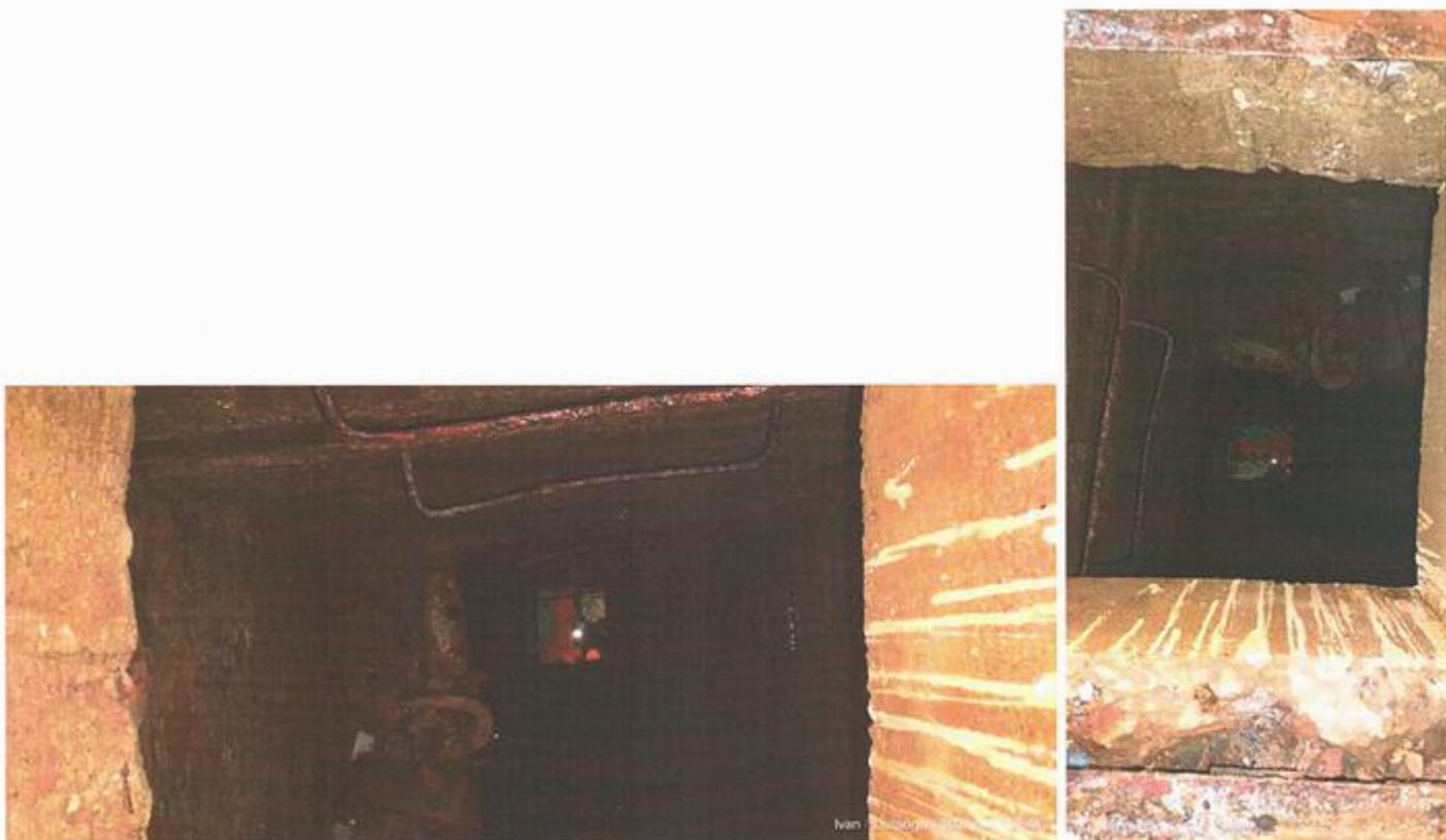
Fig. 3.6 Registro destapado, donde se observa que contiene agua.
