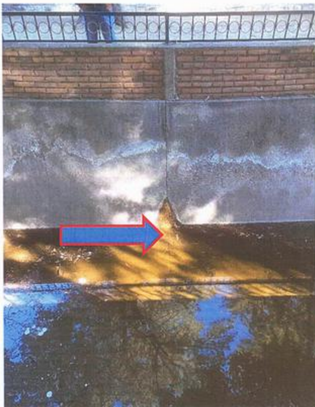
Fig. 3.1 Filtraciones en el canal que se encuentra en las afueras de la alberca.
