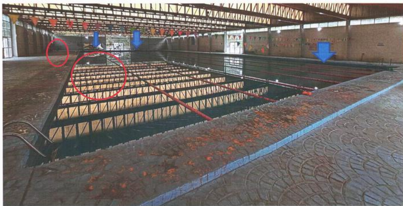
Fig. 3.4 Ubicación de asentamientos en el firme, así como remolinos y el parteaguas.
