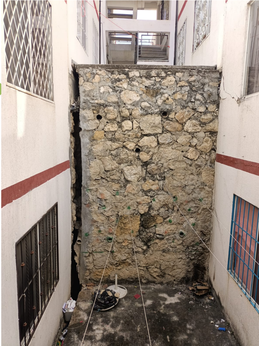
MURO DE CONTENCIÓN ENTRE EDIFICIO MZ-8-B Y EDIFICIO MZ-8-G QUE SE VÉ AL FONDO
