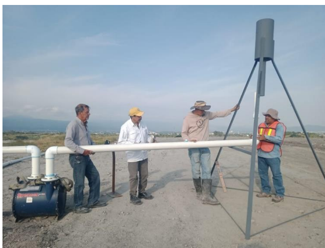
Figura 10.- Instalación de la antorcha
