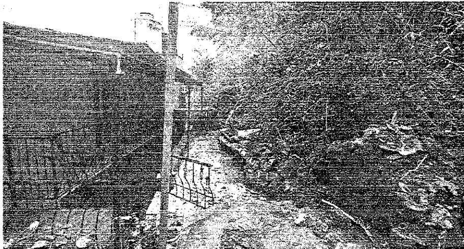
Figura 16.- Deslizamiento de tierra con colapso de una sección de lo que parece ser un muro de contención de piedra, que trajo consigo depósitos de escombros sobre la colindancia y la vivienda ubicada en calle Totonacas No. 34.
