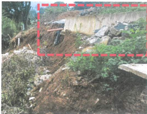
FOTO 5 Y 6: Estructura de contención carente de diseño y dimensiones adecuadas.
