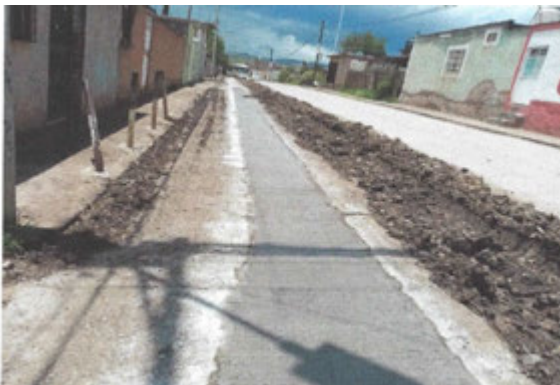
Construcción de pavimento o banqueta de concreto
