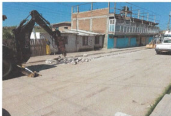
Ruptura y demolición de pavimento hidráulico
